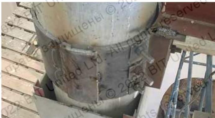
Узел крепления металлической балки к железобетонной колонне при реконструкции здания (гостиница «Пушкинская», г. Санкт-Петербург, 2010 г.)
