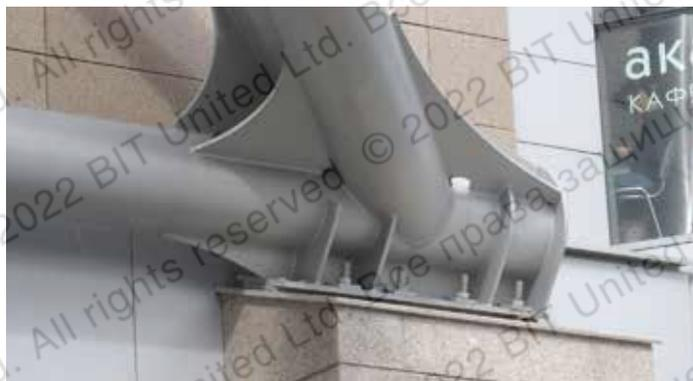
Узел крепления пространственной конструкции к плитам (минимальное расстояние от края и между осями анкеров)
