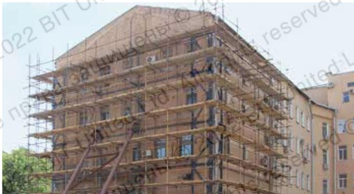
Усиление и обвязка здания, расположенного в зоне устройства котлована при новом строительстве, с многоярусной установкой анкеров с шагом 1000 мм по периметру здания (г. Москва, 2007 г.)
