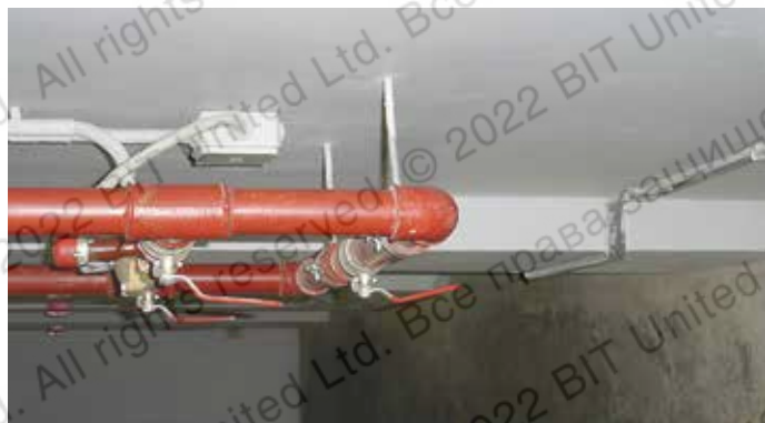
Монтаж трубопроводов высокого давления спринклерной системы пожаротушения к пустотелым плитам межэтажных перекрытий с применением сетчатых гильз
