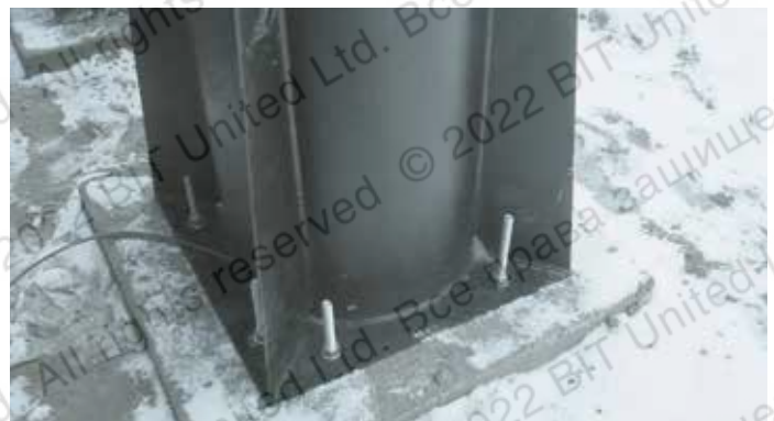
Крепление дымовой трубы тепловой станции (резьбовая шпилька M20, глубина заделки L=600 мм)
