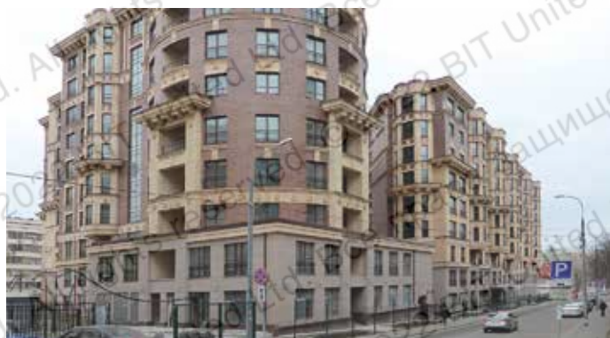
Облицовка фасада архитектурными элементами, выполненными из стеклофибробетона. Площадь фасада 10000 м 2 (многофункциональное здание, Москва, 2012 г.)
