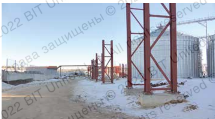
Крепление опор теплотрассы и газовой эстакады к фундаментным бетонным блокам (производство работ в условиях строительной площадки в зимний период)
