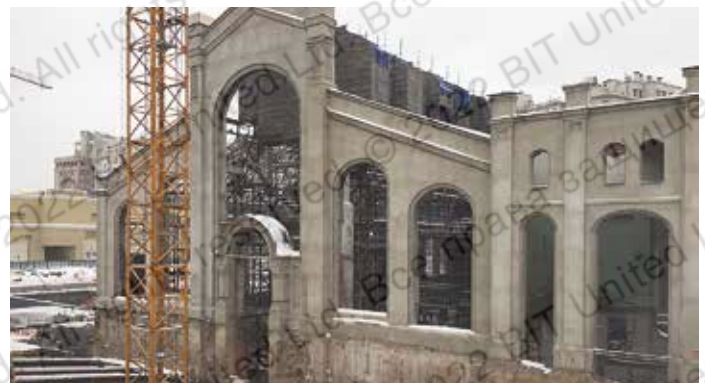
Усиление сводчатых перекрытий (Многофункциональный комплекс ГЭС-2, Москва, 2019 г.)
