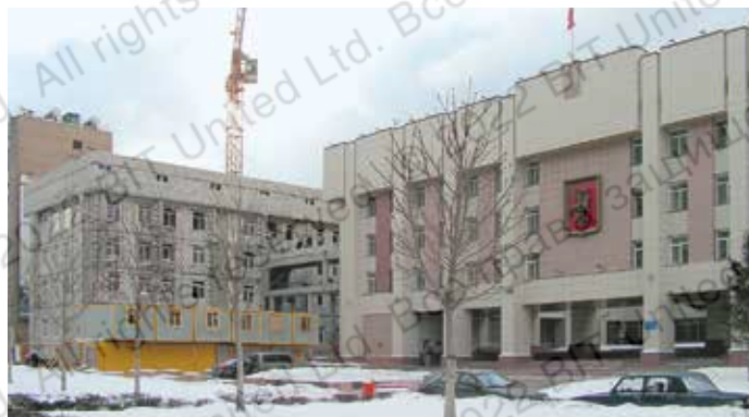
Монтаж кронштейнов фасадной системы с воздушным зазором к кладке стен из ячеисто-бетонных блоков (Центр по работе с населением и организациями Префектуры ЦАО, Москва, 2008 г.)
