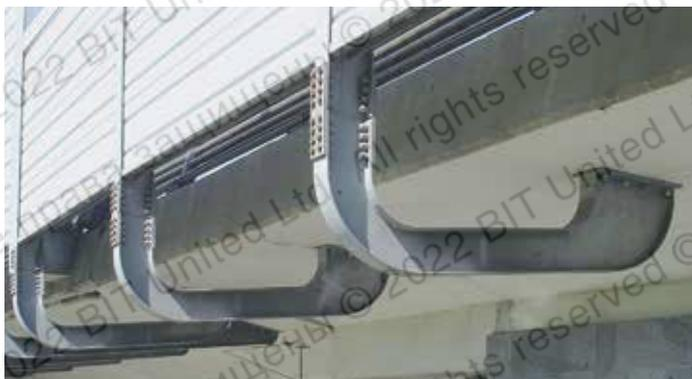
Крепление химических анкеров в нижнюю грань горизонтальных поверхностей (растянутая зона бетона)
