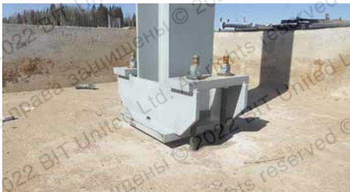
Установка стандартных фундаментных болтов для крепления колонн быстровозводимого здания (диаметр d=30 мм, глубина заделки L=1050 мм; ГОСТ 24379.1-2012, тип 5)
