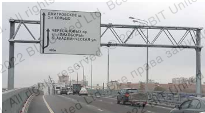
Монтаж конструкций щитов информационного обеспечения автодороги Москва – Санкт-Петербург (Северная Рокада, Москва, 2018 г.)
