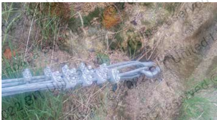
Узел крепления оттяжки кольцевой сетки динамического противоклампного ограждения энергоемкостью 500 кДж непосредственно в горную породу (глубина заделки анкера 1500 мм)
