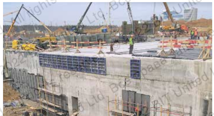
Организация арматурных выпусков при строительстве многоуровневой развязки и тоннеля под Калужским шоссе в районе ТПУ «Столбово» (Москва, 2018 г.)
